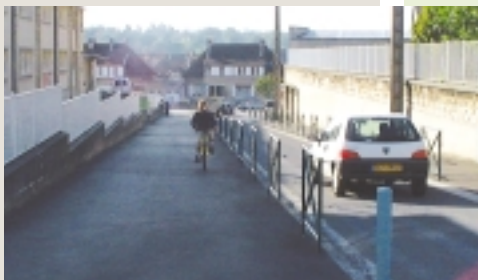
élargissement des trottoirs rue des Prémontrés
