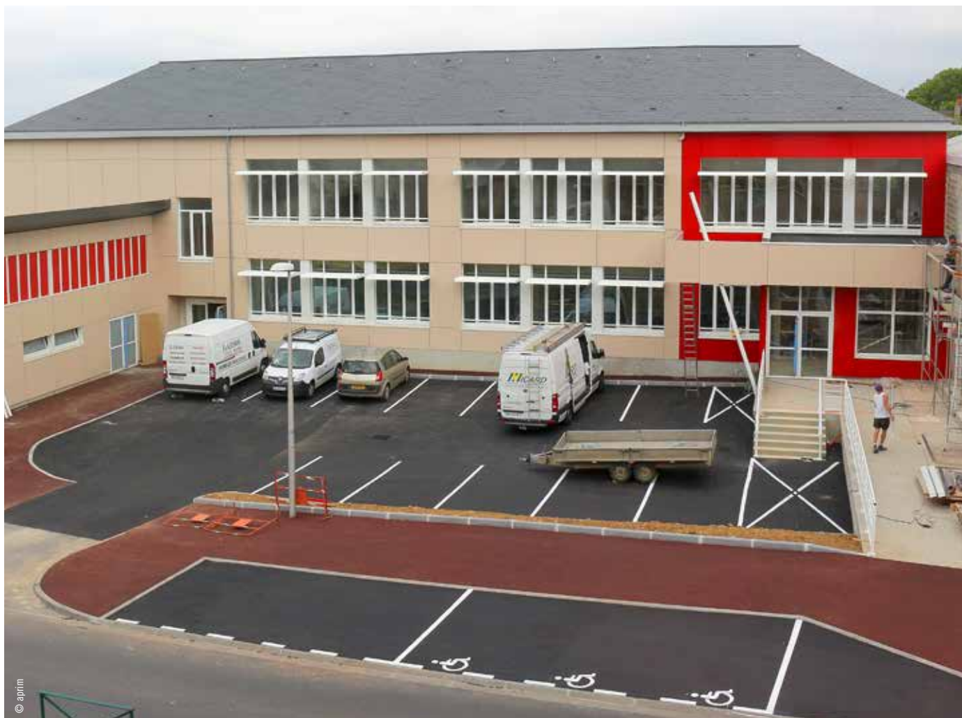
Les travaux ont duré tout l'été pour permettre l'ouverture du Centre Socioculturel à la rentrée.
