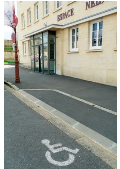
À l'Espace Nelson Mandela, un ascenseur et une place de stationnement ont été spécialement aménagés.
