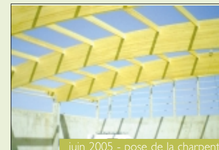
juin 2005 - pose de la charpente
