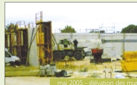
mai 2005 - élévation des murs
