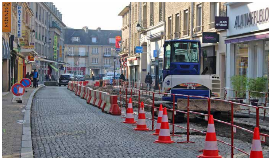
Les commerces de la rue de la Pelleterie restent ouverts pendant toute la durée des travaux !
