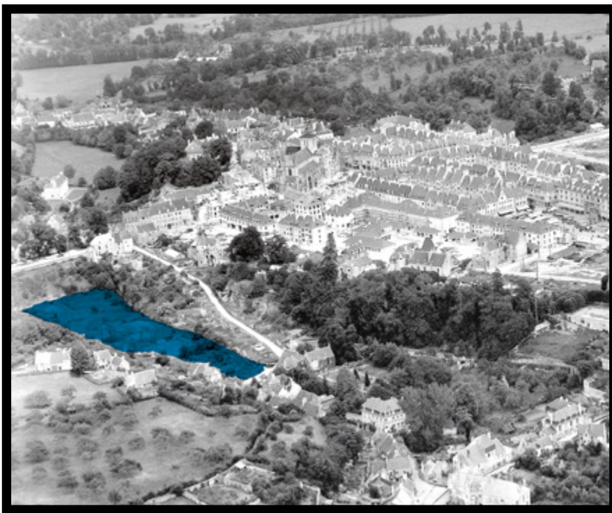
Falaise lors de sa reconstruction. L'emprise du futur plan d'eau matérialisée en bleu.
