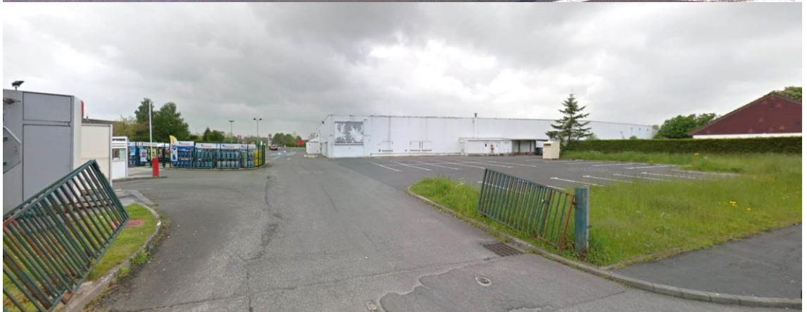
Bâtiment existant sur le site faisant l'objet de la modification simplifiée
